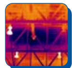
屋顶/水渍损害
